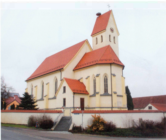
Grimolzheimer Kirche nach der Sanierung 2012 (Fotos G. Mayer)
