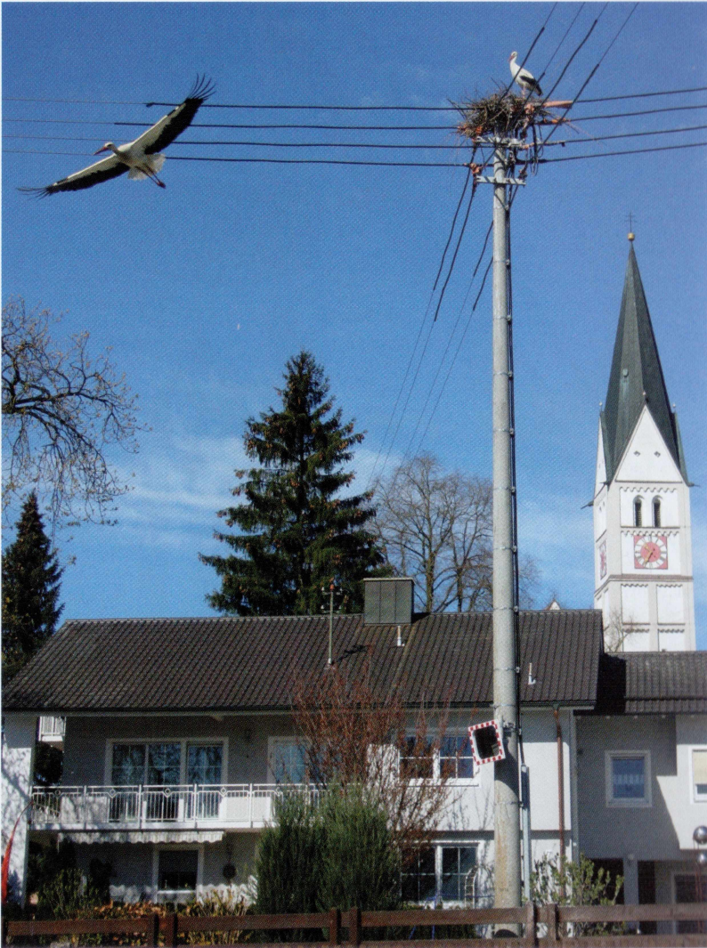
Isolierter Strommast der Lechwerke in der Hofstelle der Familie Elbl (19.4.2012)
