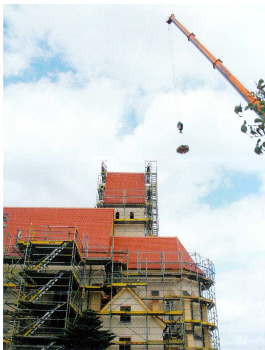
Einsatz des Baukrans in Grimolzhausen
