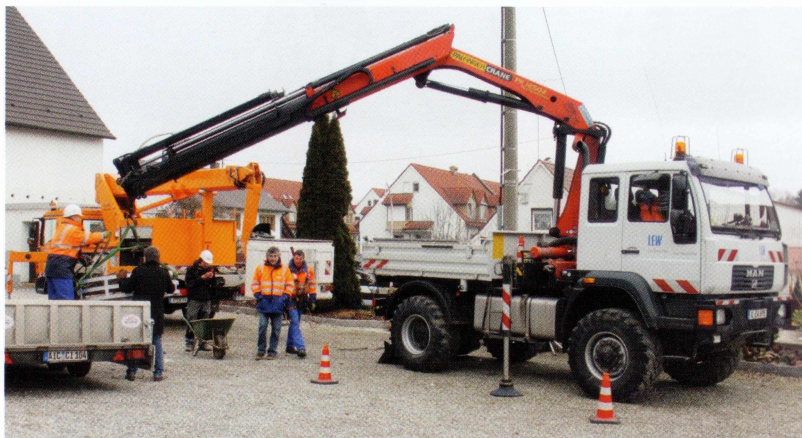
Am 20. Dezember 2012 stellten die Lechwerke zwei Lkw zur Montage des neuen Stahlkorbes zur Verfügung.
