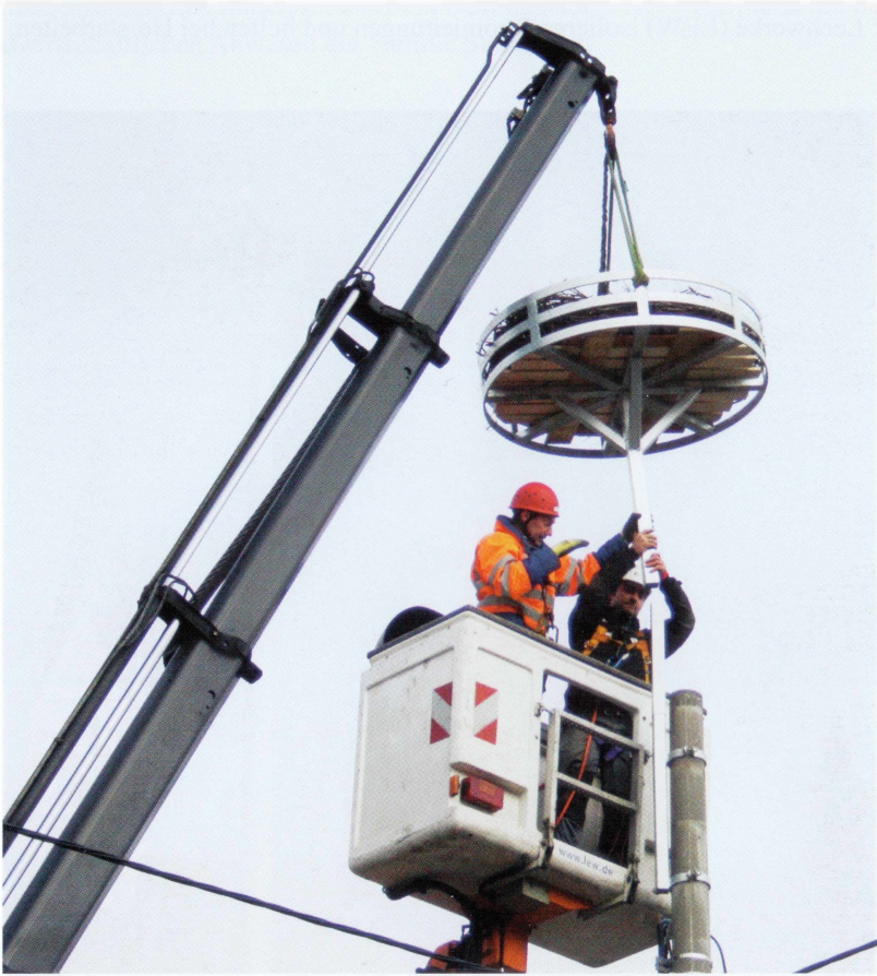
Alexander Ankner (re.) und LEW-Monteur Helmut Lindermeir montieren den Stahlkorb an die neuen Schellen des Betonmastes.
