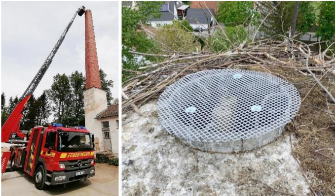
Abbildung 22: Feuerwehr im Einsatz (links). Gelungene Konstruktion des städtischen Bauhofs (rechts). Noch spärlicher Nisteintrag der Störche (Stadt Aichach, 2020)
